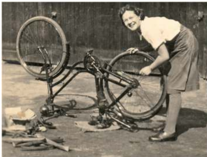
▲ Bei einem Phänomen aus Kriegsproduktion wird das Hinterrad wieder eingebaut, Gepäckträgerstreben müssen noch befestigt werden, ein Putzlappen liegt unter dem Sattel zum Schutz. Pappverpackung, Werkzeug, Luftpumpe und einige Schläuche liegen neben dem Rad.
