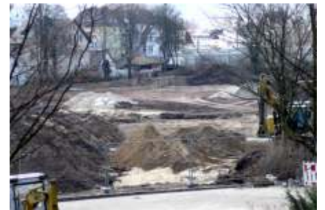
Abb. 8 Die Innenfläche der Bahn wurde 1,20 m tief ausgebagert
