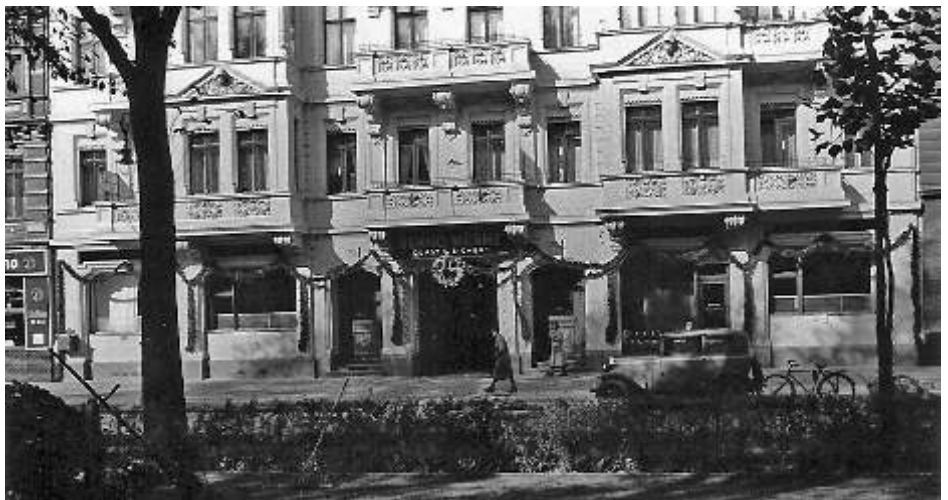
Zweimal Unternehmenssitz Greifswalder Straße, Berlin 1935: Verladesituation im Hof (oben), Außenansicht zum 25jährigen Jubiläum (unten). Rechts der Einfahrt befand sich das Ladenlokal.
