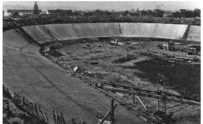
Der halb fertige Bau der Rennbahn im November 1952. Links im Vordergrund sind die senkrecht stehenden Armierungseisen der späteren Betonbrüstung gut zu erkennen. Die Ränge fehlen noch, der Innenraum ist Baustelle. Foto: Hermann Rieger
