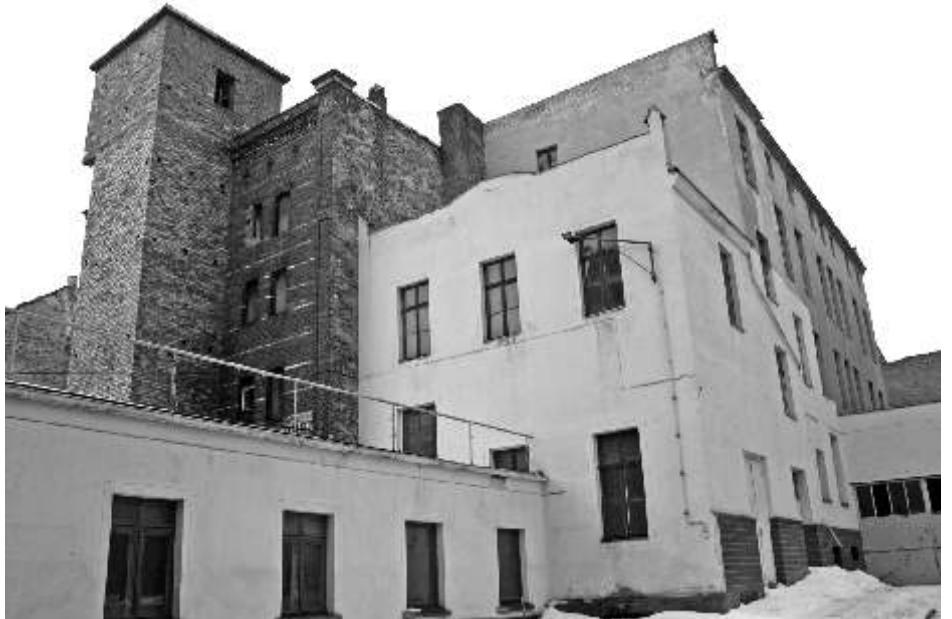
Alle Molto-Werksgebäude (der Ziegelbau gehört nicht dazu) werden abgerissen.
