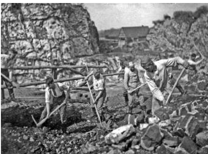
Arbeiten mit Spitzhacke und Spaten, Mai 1935.
